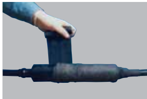
6. Для повышения жесткости муфты весь корпус муфты обматывается лентой Armorcast™ (включается в набор по требованию)
